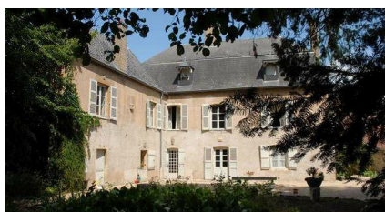
© La Maison des Gardes / Beaulieu
